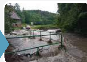
Zanesení vtoku do zatrubnění Dalejského potoka (25. 6. 2022)
